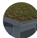
Sedum-Dach (begrünbares Dach)
