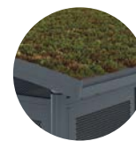
Sedum-Dach (begrünbares Dach)
