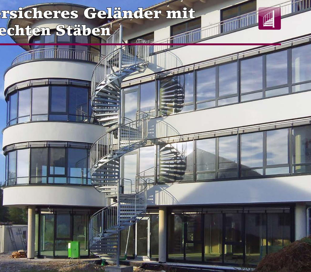
Das Rundstabgeländer ist wie das Bügelgeländer eine kindersichere Variante mit max. 120 mm Abstand zwischen den Geländerstäben. Zusätzlich hat es einen Ober- und einen Untergurt aus Flachstahl 25x8 mm. Dieser Geländertyp wird nicht bei Express-Treppen gefertigt.
